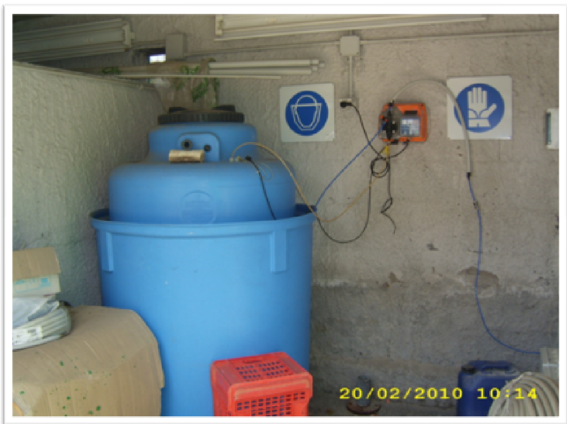
Acque di Casalotto - Impianto di clorazione "Pozzo Amato"
