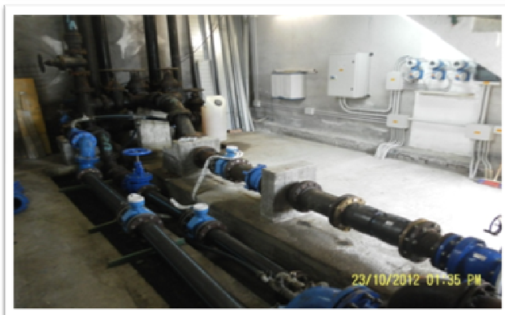
Serbatoio Campo Sportivo - L'impianto di risalita dell'acqua
